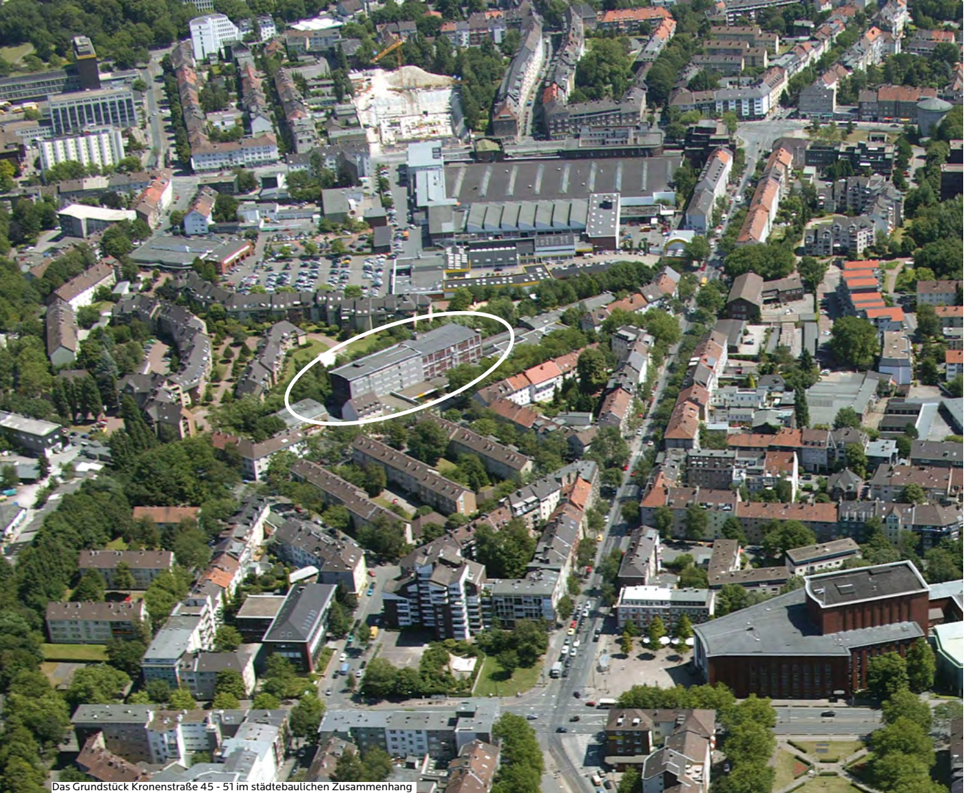
Das Grundstück Kronenstraße 45 - 51 im städtebaulichen Zusammenhang
